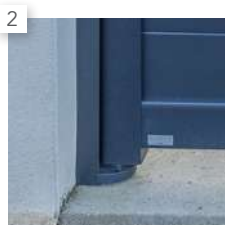
Gonds haut et bas anti dégondage avec battement cache-jour intégré
