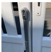
Verrou baïonette déverrouillage manuel par clé
